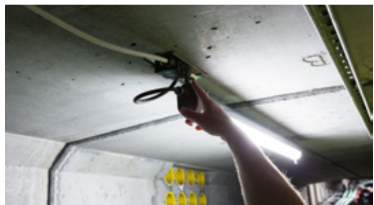
Armaturene har hurtigkobling samt gummioppeng for å dempe vibrasjoner.
