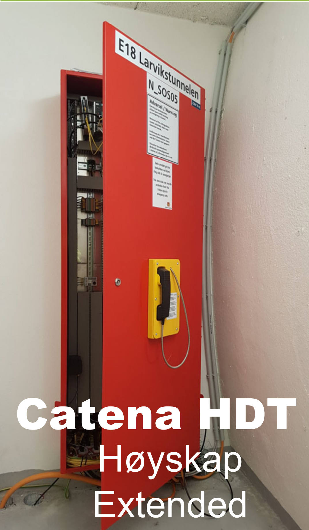
Duetto VoIP Nødtelefon innfelt i dør
