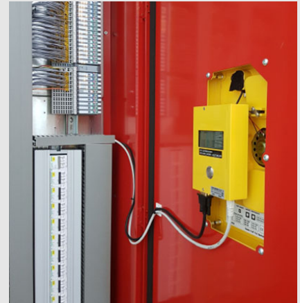
Duetto VoIP Nødtelefon innfelt i dør
