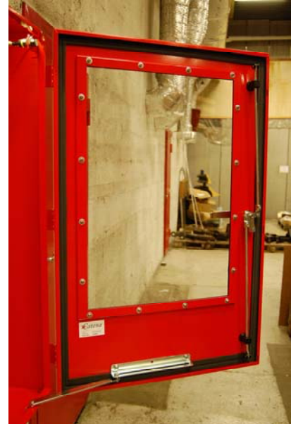
Døra har 3-punkts lås og skrudd vindusramme.
