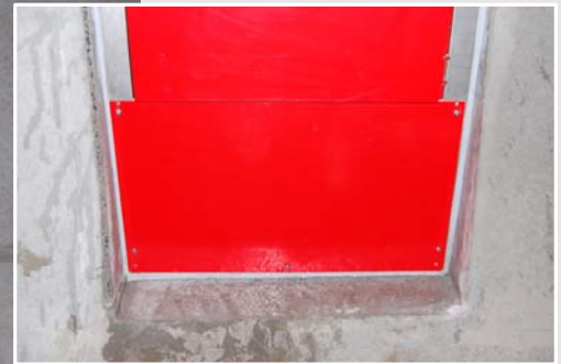
Rom for kabelinnføring med skrudd dekkplate
