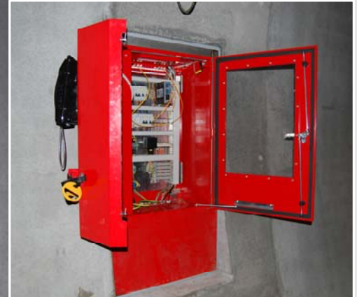
Innfelt HDS2 Basis nødskap i Eidsvolltunnelen
