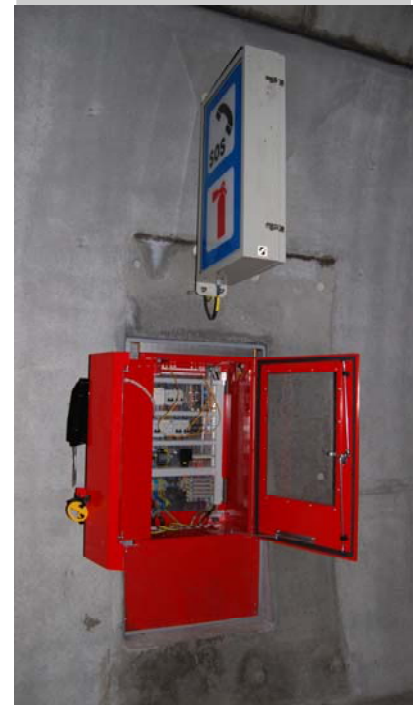
Catena HDS2 Basis nødskap innfelt i HDR karm i Eidsvolltunnelen
