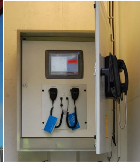
Plass for nødstyrepanel og radio innsnakkspanel i svingbar skillevegg (viser HDK Extended)
