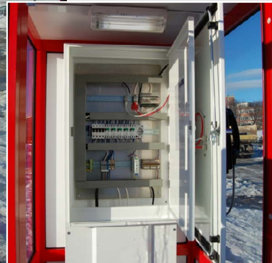
Stort servicevennlig teknisk rom bak hengslet skillevegg (viser HDK Basis)
